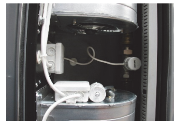
kuva verholiitännästä venttiili asennettuna
