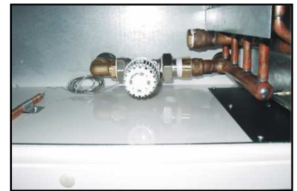
kuva sisäänrakennetusta termostaattiventtiilistä
