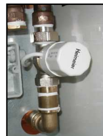
kuva sisäänrakennetusta termosähköisestä venttiilistä
